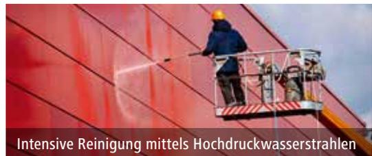
Intensive Reinigung mittels Hochdruckwasserstrahlen
