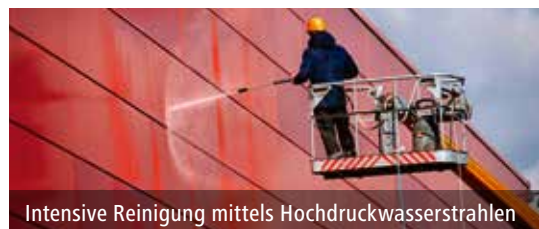
Grobe Reinigung mittels Wasserstrahlen
